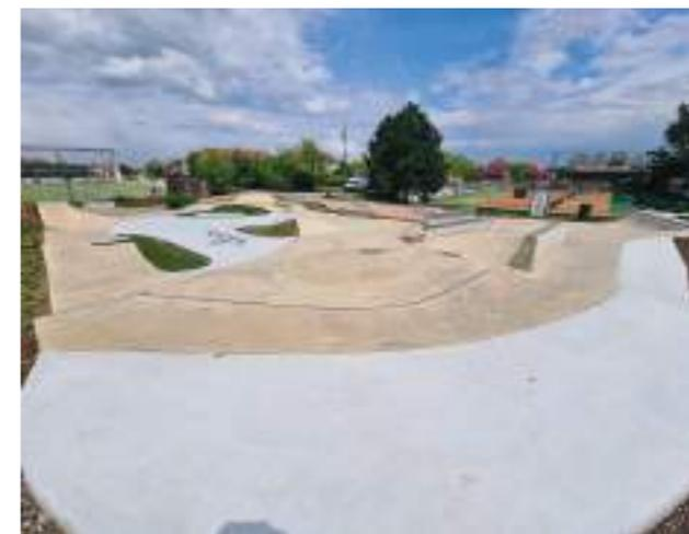
**Au skate parc :** il a été procédé au rajout de cheminements au milieu de l'équipement avec un manual pad et un rail ainsi que l'extension des plateformes pour la réception des sauts. Cela permet à nos sportifs d'évoluer plus librement et d'effectuer des variantes dans l'exécution des rides.
