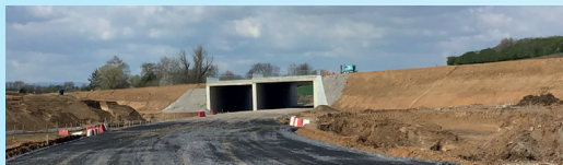
RD 61 vers Berstett avec passage sous la future autoroute. Réouverture prévue début juin.
