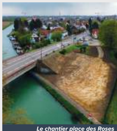
Le chantier place des Roses
