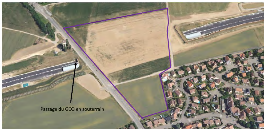
Figure 9 – Vue aérienne du bassin versant intercepté avec passage en souterrain du GCO
